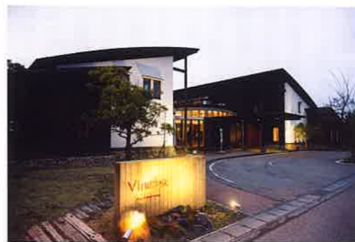
大きな中庭を囲み、北と南の2棟に分かれるヴィネSPA。客室は1階と2階に計7室。和食レストランやカフェ、温泉は1階にある。
